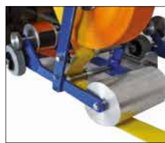
Step 7 Procedere con l'applicazione dello strato adesivo sul pavimento assicurandosi che passi sotto il rotolo d'alluminio.
